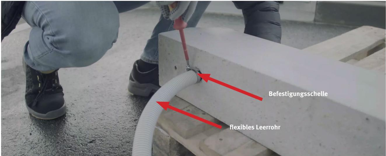
Abb. 9: Leerrohre anschließen
