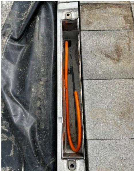
Abb. 23: Verbauter Bordstein mit Anschlussleitung – Länge 1 m
