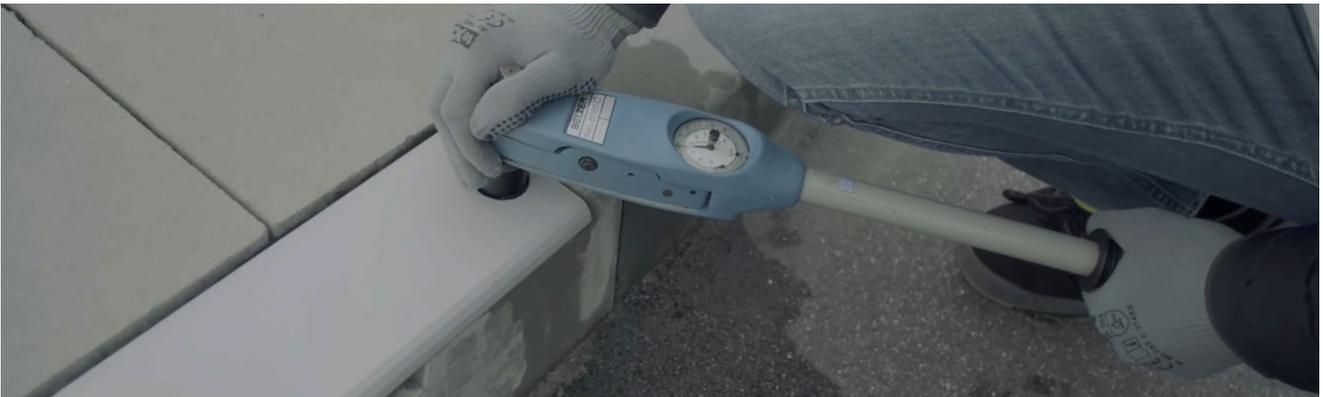
Abb. 19: Schutzdeckel ausrichten und Sicherheitsschrauben festziehen
