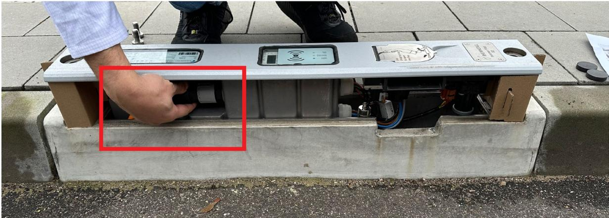
Abb. 34: Anschlussstecker verriegeln
