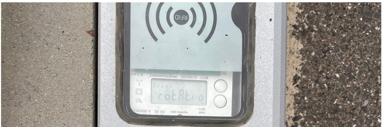
Abb. 42: Drehfeld falsch – Anzeige des Energiezählers
