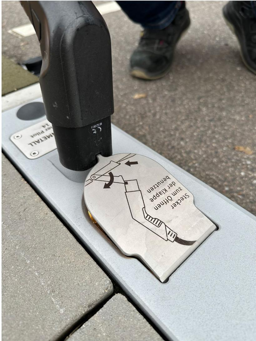
Abb. 43: Einhandbedienung zum Öffnen der Verschlussklappe
