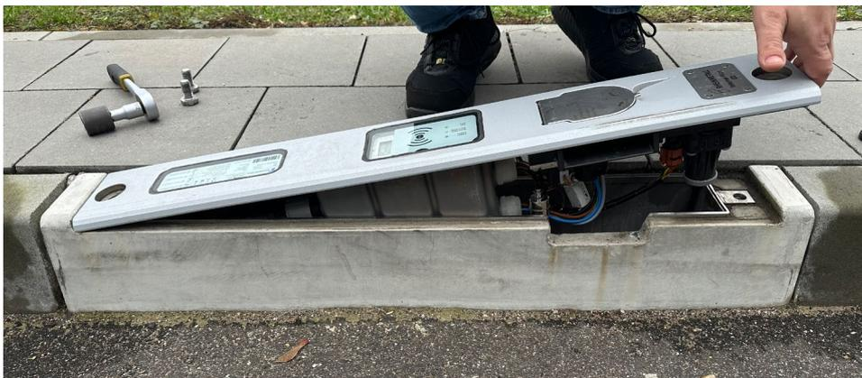
Abb. 35: Elektronikmodul in den Bordstein ablassen
