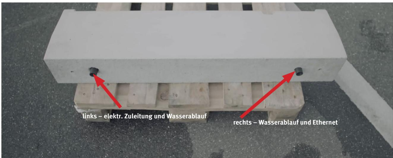
Abb. 8: Flexible Leerrohranschlüsse an der Ladebordstein-Unterseite anbringen
