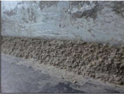
Verfüllter Zwischenraum mit TerraFill-M
