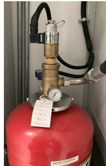
Abbildung 4-16: Befestigung des Aktuators
