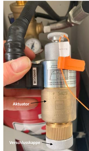
Abbildung 4-14: Entfernen der Verschlusskappe
