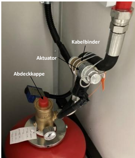
Abbildung 4-13: Entfernen von Abdeckkappe & Kabelbinder
